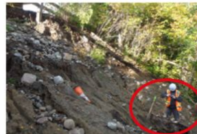
Ne pas descendre à l'intérieur du glissement
